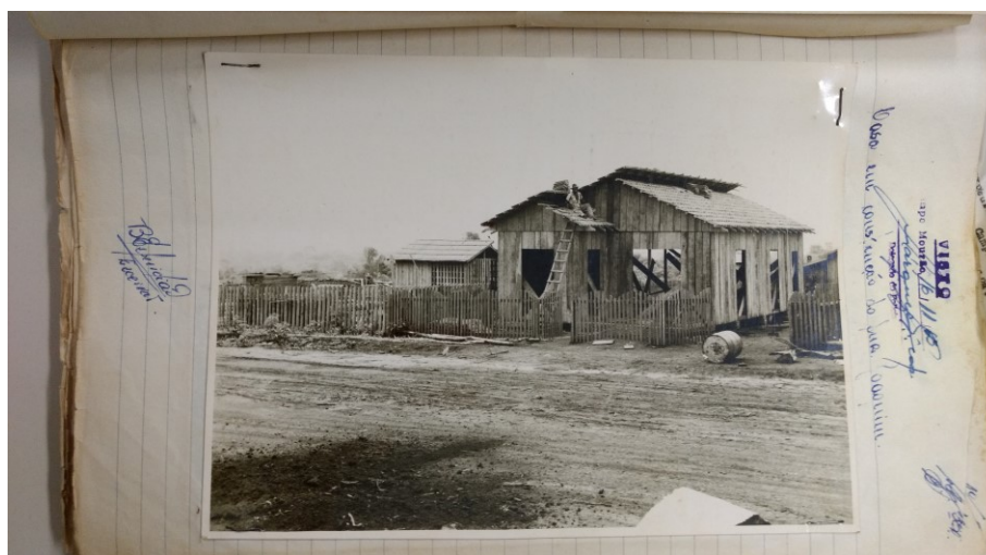
Figura 15 – Construção de uma casa em Campo Mourão em 1965 (Autos 135/65) Fonte: Arquivo da Primeira Vara Criminal de Campo Mourão-PR
