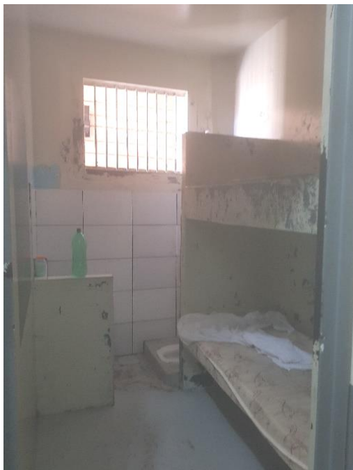
Figura 12 - Foto interna do alojamento A1
