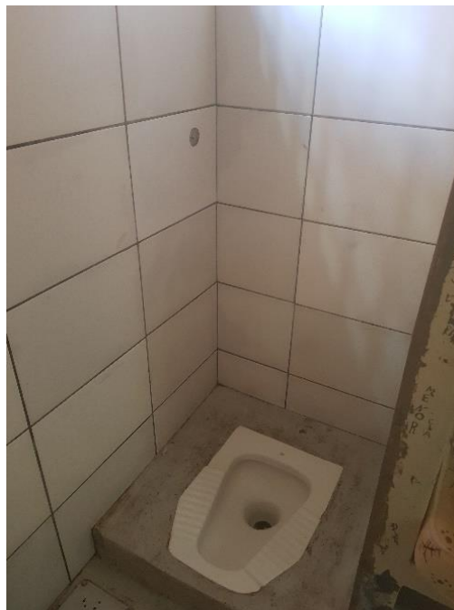
Figura 13 - Foto do sanitário do alojamento A1
