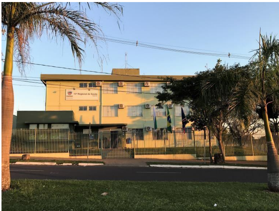
Figura 53 – Edifício da 13ª Regional de Saúde de Cianorte.
