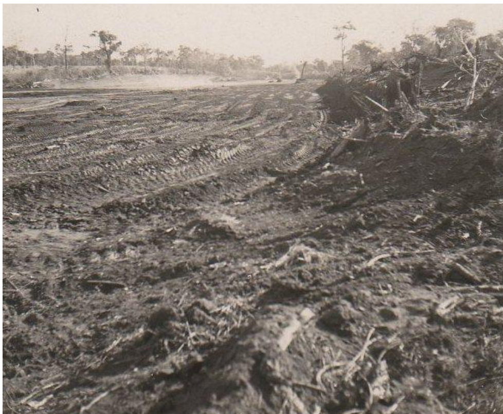
Figura 98 – Serviço de terraplanagem para construção da ferroviária 1953.
