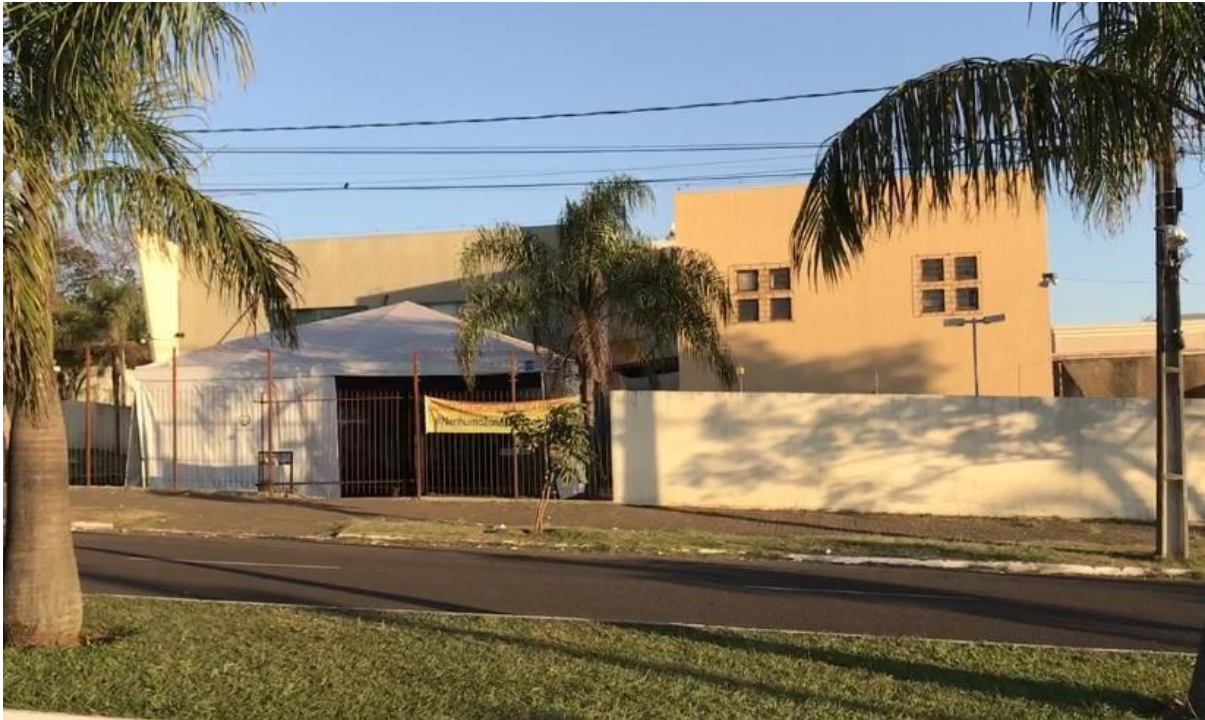
Figura 47 – Edifício do Tribunal Regional Eleitoral do Paraná.
