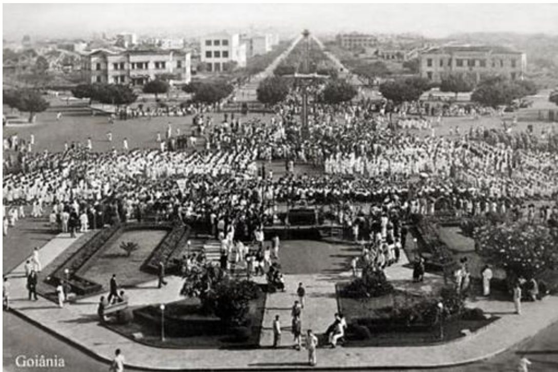
Figura 20 – Centro administrativo de Goiânia, décadas de 1950 a 1970.
