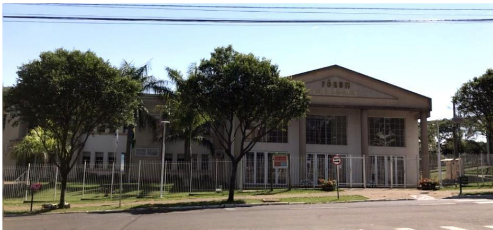
Figura 44 – Edifício do Fórum Juiz Itari Cerqueira Leite.
