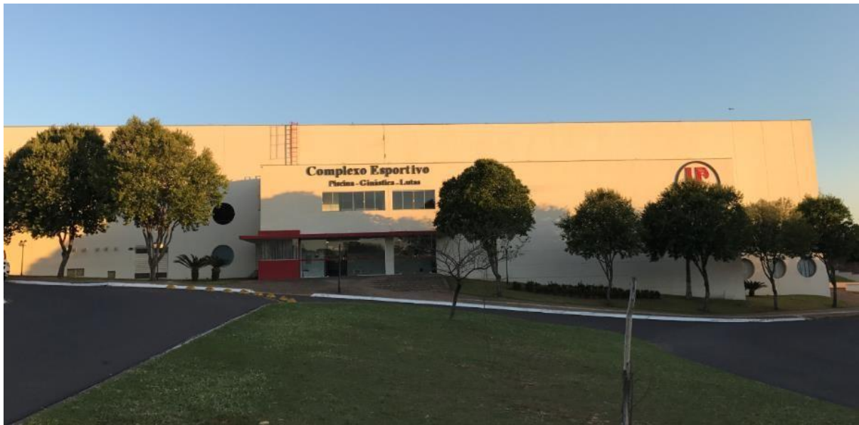
Figura 48 – Centro Esportivo da APEC, edificado sobre a quadra 65.
