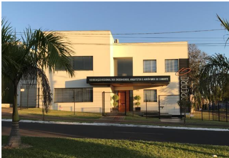
Figura 50 – Edifício da AREARC.
