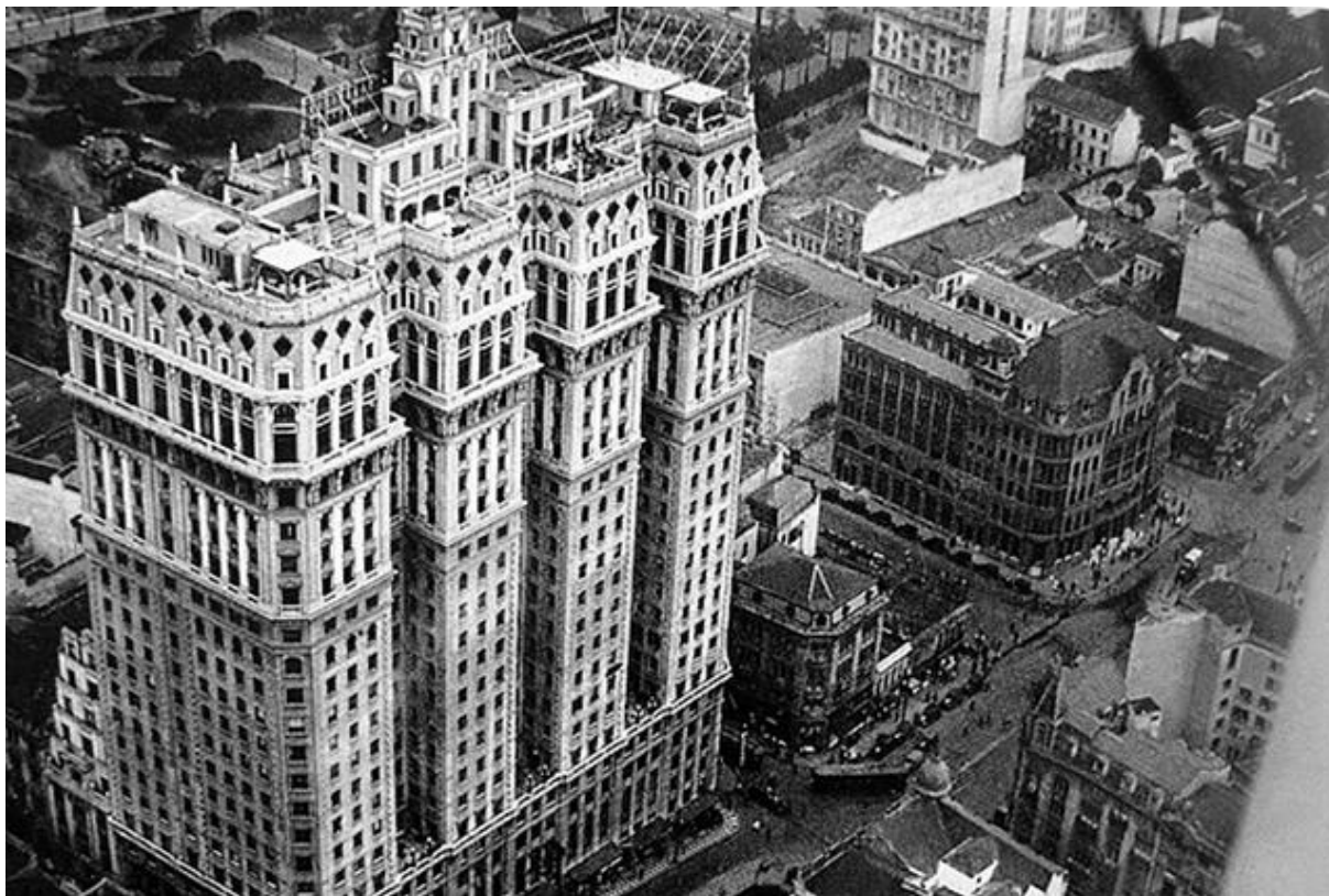
Figura 87 – Edifício Martinelli, 1929, São Paulo-SP.
