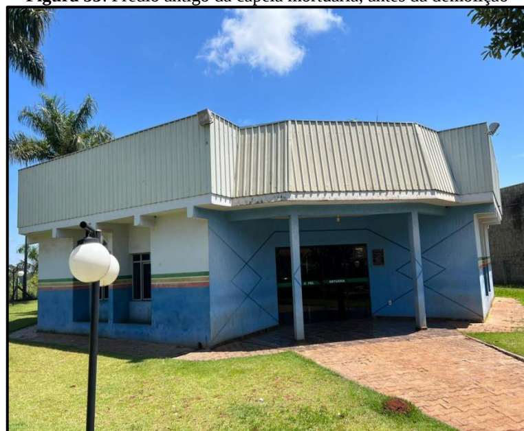
Figura 55: Prédio antigo da capela mortuária, antes da demolição
