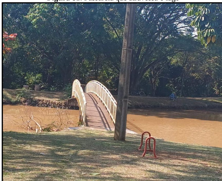
Figura 81: Passarela que atravessa o lago
