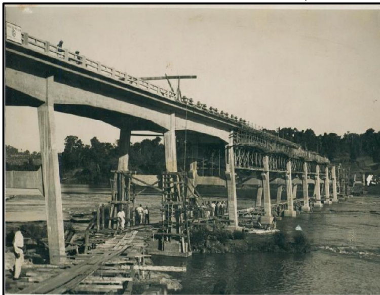
Figura 9: Ponte do rio Ivaí construída em concreto armado, na década de 1950
