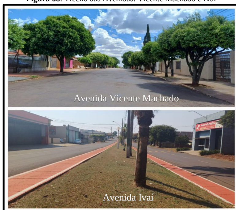
Figura 68: Trecho das Avenidas: Vicente Machado e Ivaí
