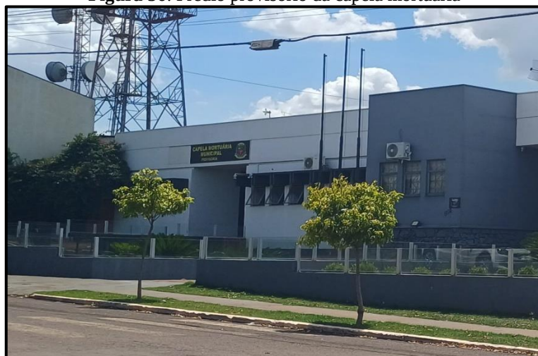
Figura 56: Prédio provisório da capela mortuária
