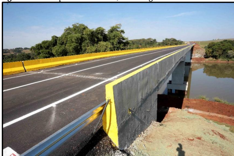
Figura 42: Nova ponte do Rio Ivaí, entre Engenheiro Beltrão e Floresta
