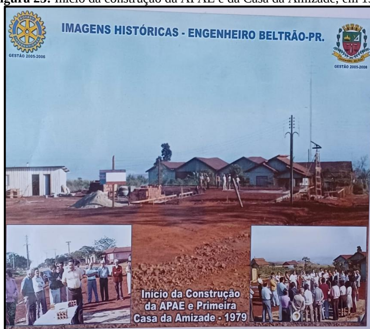
Figura 25: Início da construção da APAE e da Casa da Amizade, em 1979
