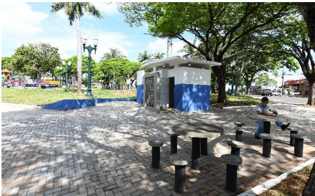
Figura 10 - Imagens banheiro Praça Alto São Francisco 2024
