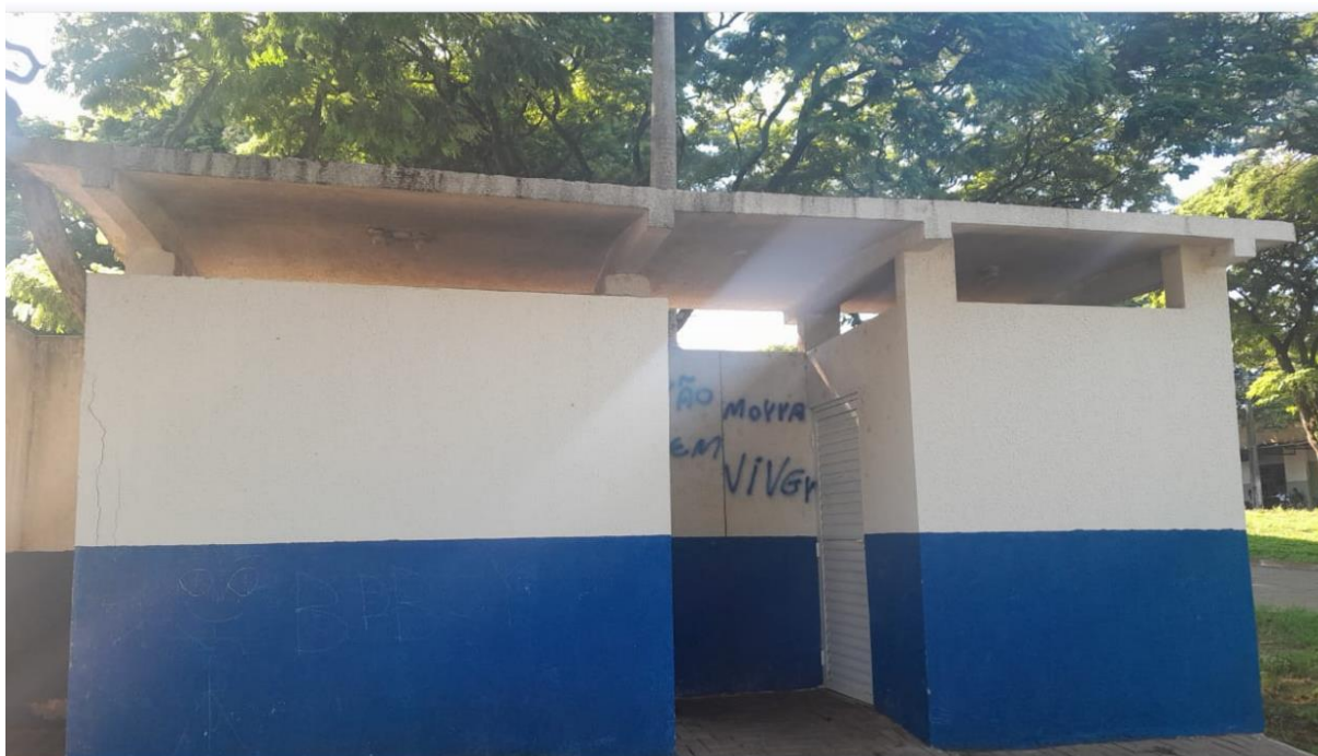
Figura 12 - Imagens banheiro Praça Tamoio 2024
