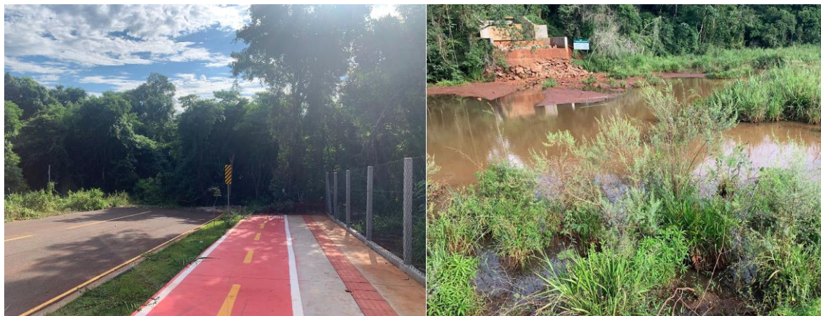
Figura 10 – Área externa e interna do local onde será construído a ponte que ligará o condomínio ao parque
