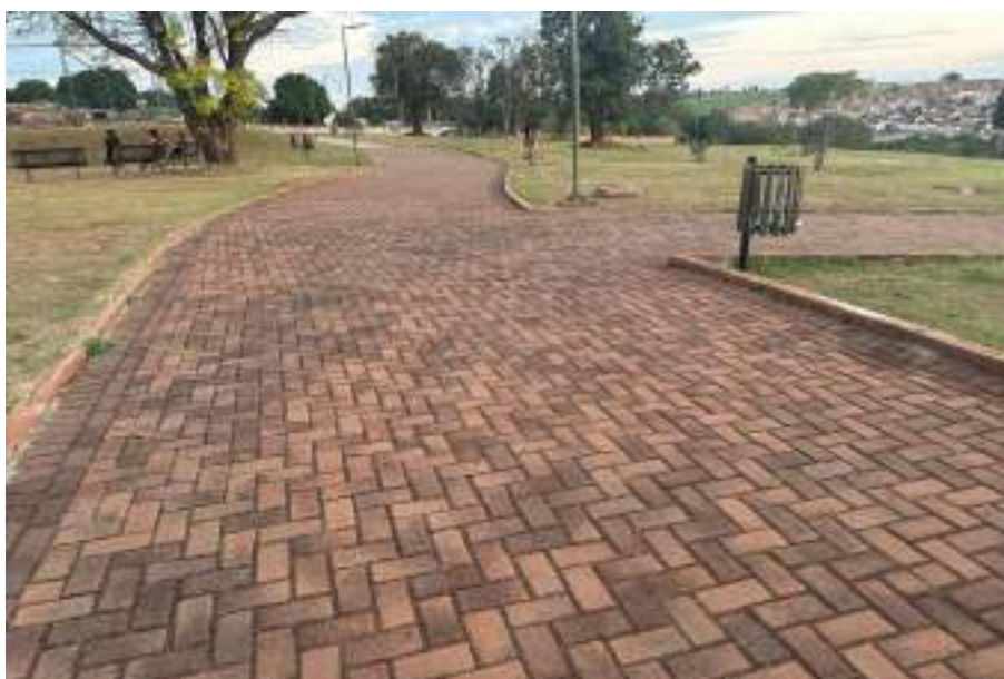
Figura 32 - Piso da entrada principal
