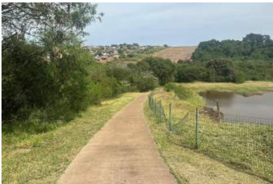
Figura 33 - Piso de concreto
