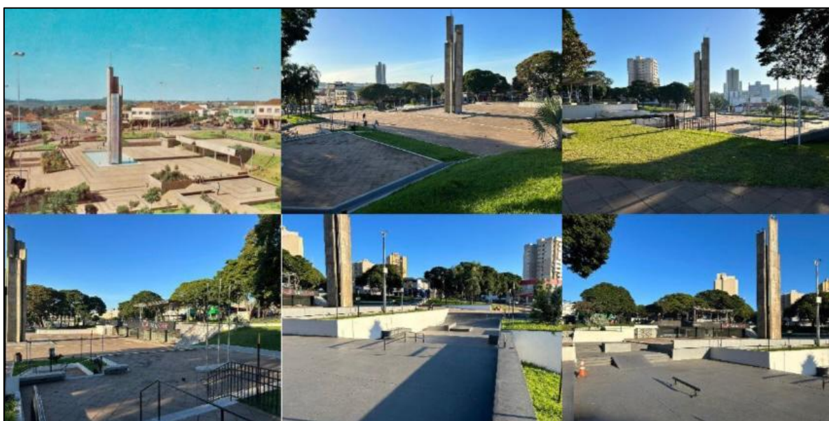
Figura 16 – Estrutura e equipamentos da Praça Santos Dumont
