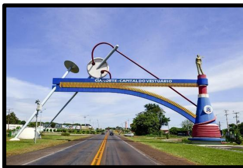
Figura 2 - Pórtico do Município de Cianorte
