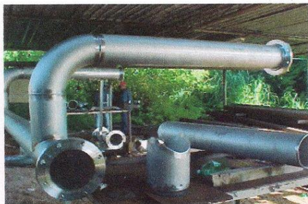
Foto 3 – imagem dos tubos restaurados e substituídos.
