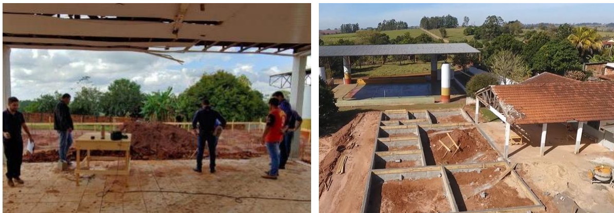
Figura 07 e 08 - Construção do novo prédio da escola (2020)
