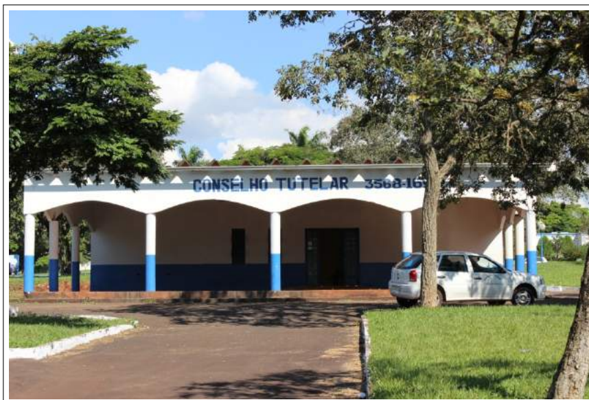
Figura 26: Prédio Institucional – Conselho Tutelar de Mamborê. Foto: Tatiane Monteiro Ré, 2016.
