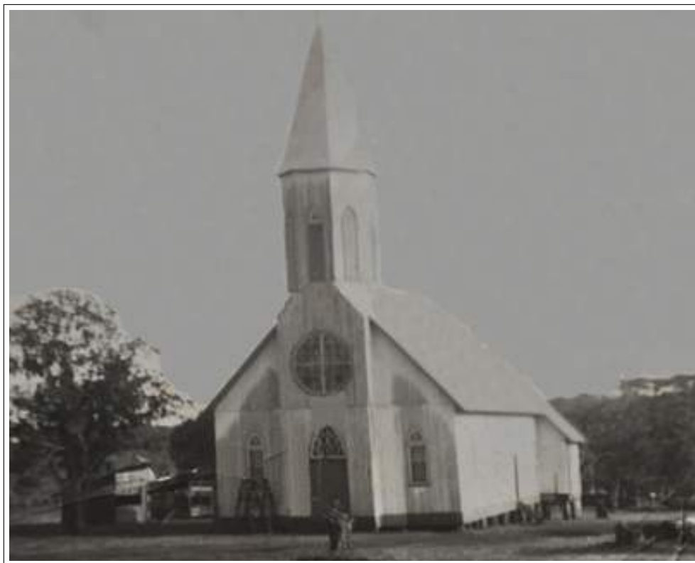
Figura 16: Vista parcial da capela construída na década de 1950. Fonte: http://trnoticias.com.br/fotoshistoricasmambore/index3.html .
