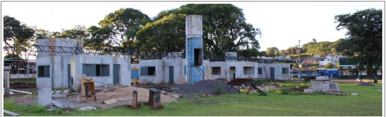
Figura 52: Obras de reforma na Praça das Flores Foto: Tatiane Monteiro Ré, 2016.
