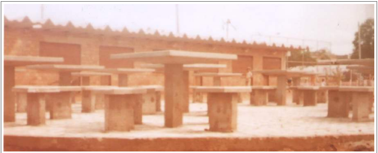
Figura 7: Praça das Flores em construção. Foto: cedida por Ubiraci Pereira Messias.
