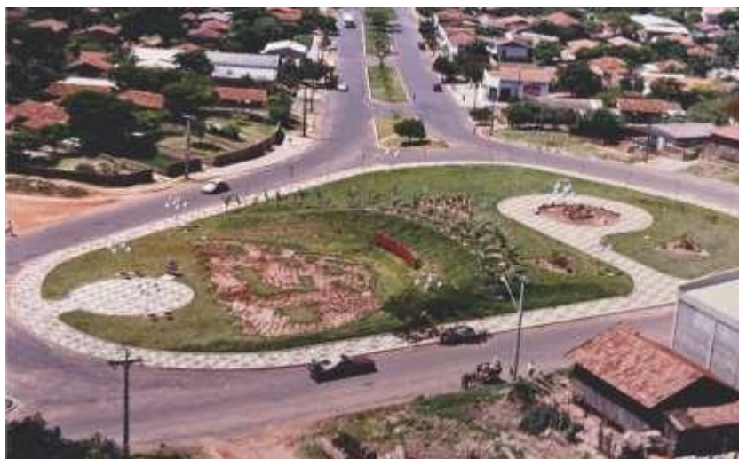
Figura 63: Vista aérea Praça Portugal em 1975
