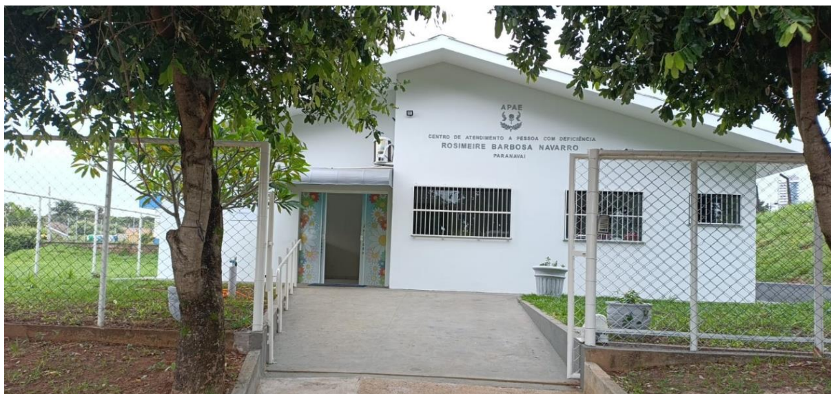
Figura 01 - Fachada do CAPD.
