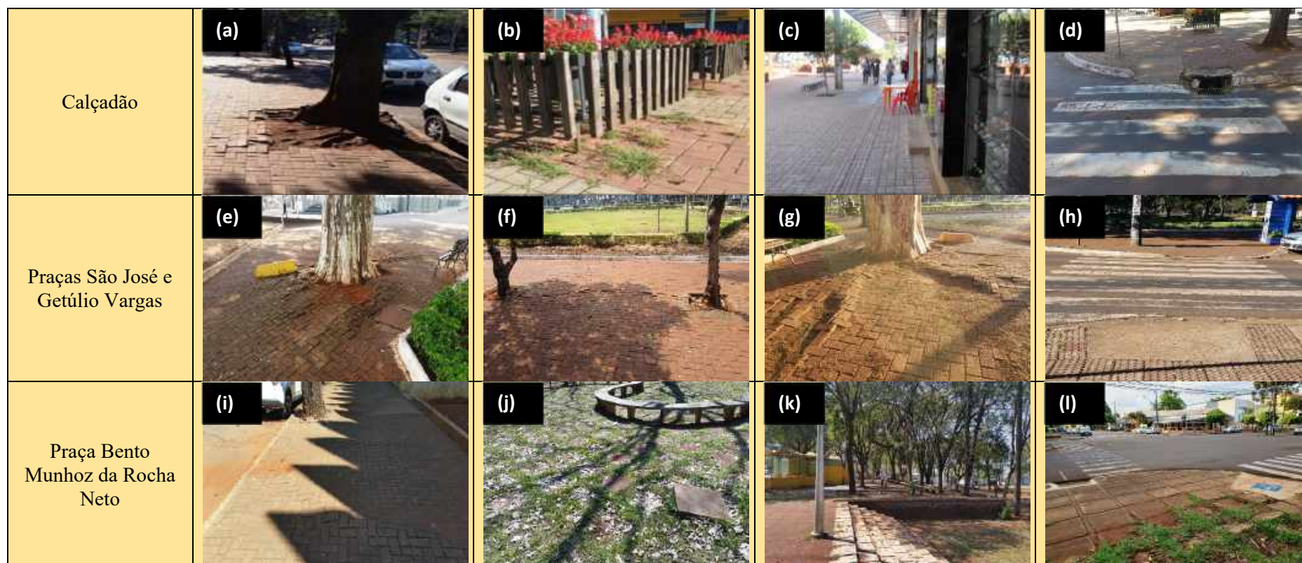
Figura 37: Mobilidade interna/externa: a pavimentação, o piso tátil e os rebaixos.
