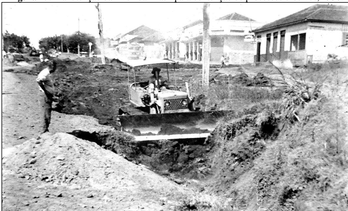
Figura 15: Manutenção da Avenida Brasil para contenção de processos erosivos, 1950.
