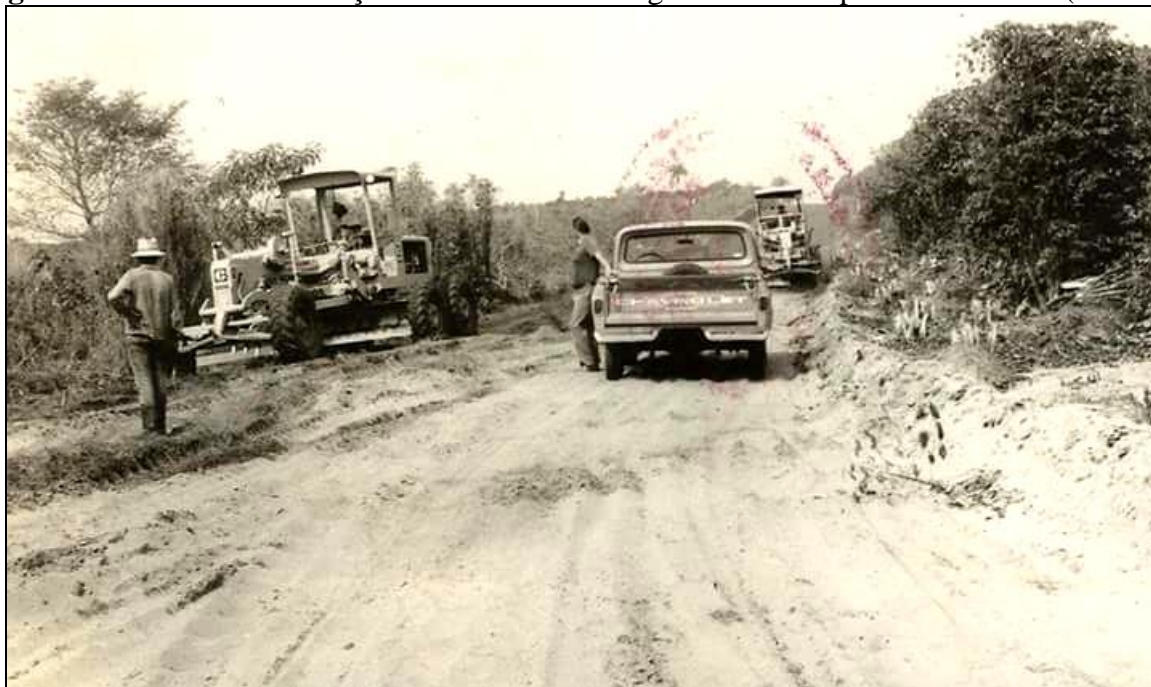
Figura 7: Abertura e construção de estradas de rodagem no município de Terra Boa (c. 1960).
