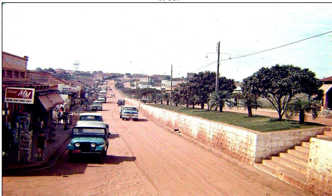
Figura 18: Vista da Avenida Brasil com destaque para o canteiro central e a iluminação pública, com a caixa da água da Estação de Tratamento de Água da SANEPAR ao fundo, 1968.
